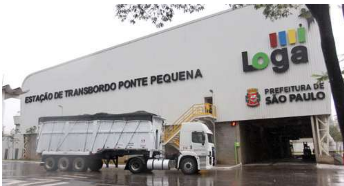
Figura 06 – Imagem da fachada da Estação de Transbordo Ponte Pequena
