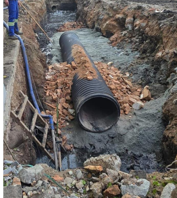
Escavação e substituição de manilhas quebradas em setembro de 2025.
