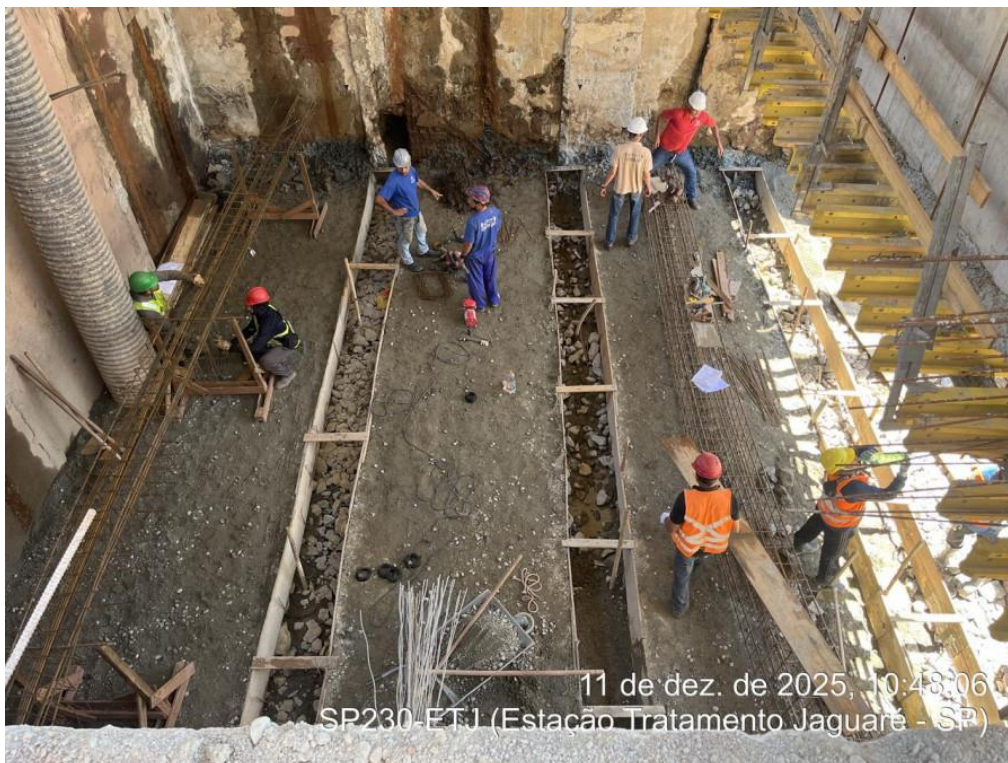
Execução da laje de subpressão – Início em dezembro/2025.
