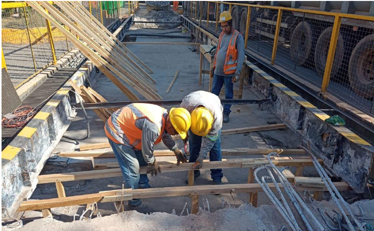
Montagem das estruturas para nova plataforma em maio de 2024.
