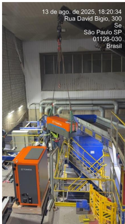
Colocação dos seletores óticos e seus componentes em agosto de 2025.
