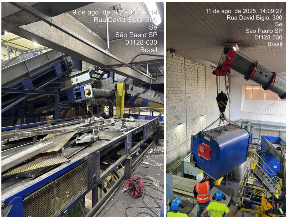
Desmontagem de esteiras transportadoras e retirada de seletores óticos antigos em agosto de 2025.
