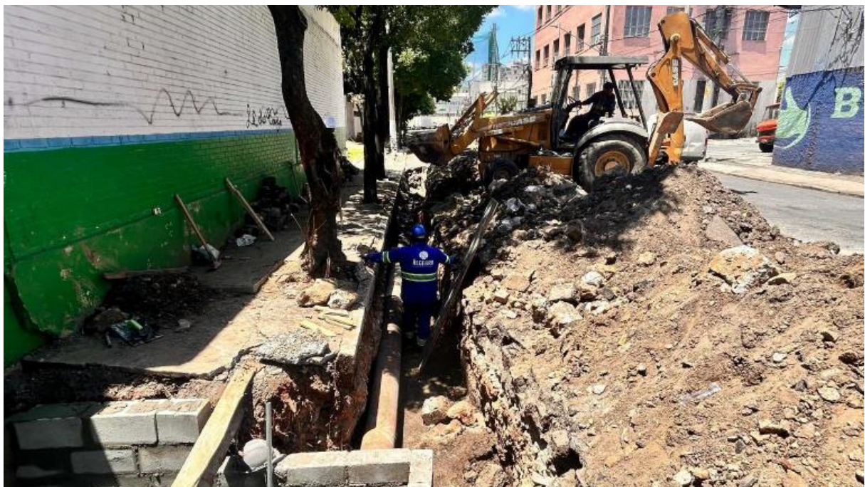
Obras para a conexão da drenagem da Unidade com a rede da Sabesp realizadas em novembro de 2025.
