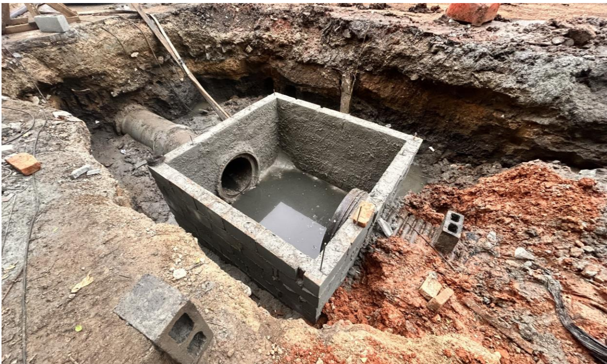
Construção de poços de visita e adequação das conexões da rede de drenagem em setembro de 2025.
