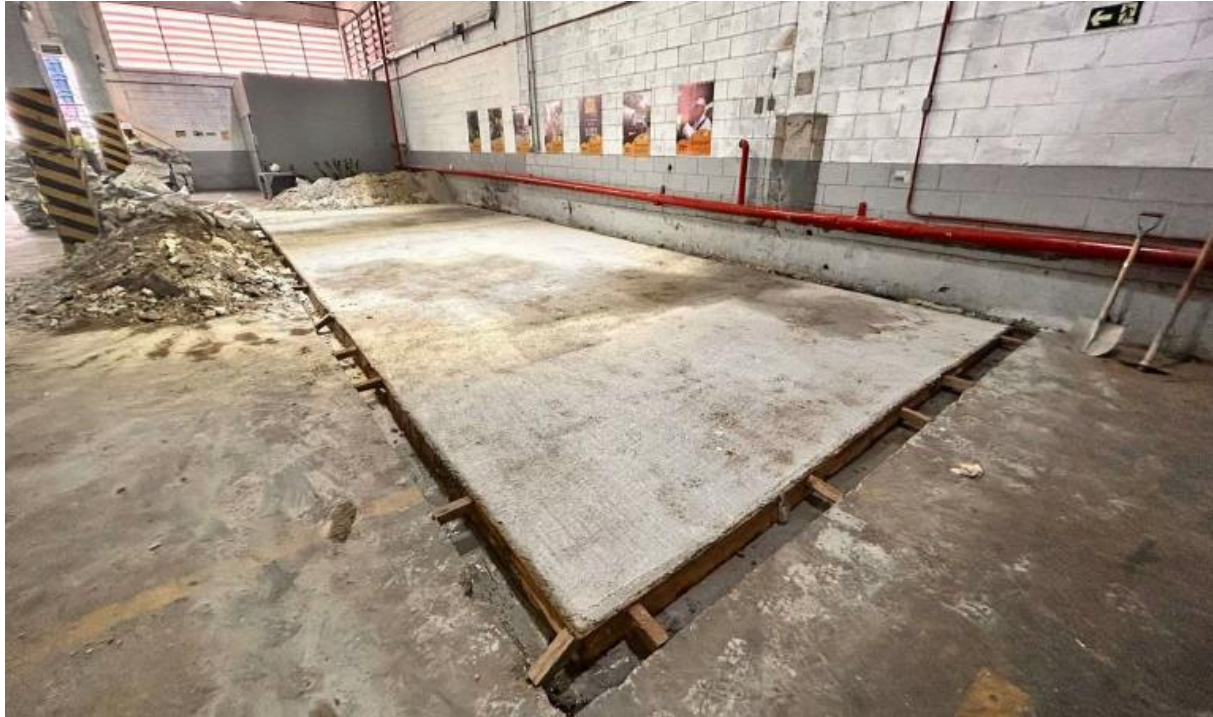
Trecho do piso da Central Mecanizada reconstruído para receber nova prensa em outubro de 2025.
