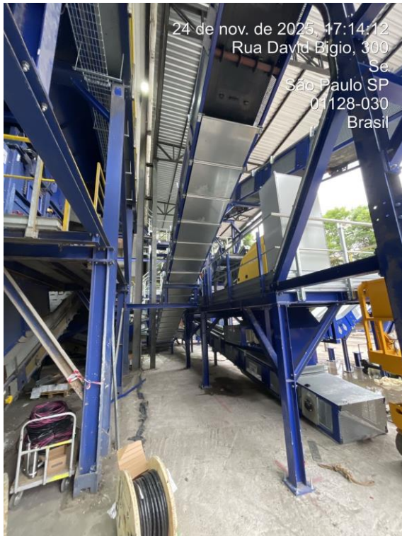
Instalação de novas esteiras transportadoras e de quadros elétricos dos novos equipamentos em novembro de 2025.
