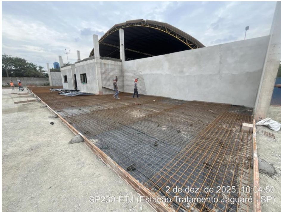
Execução do pavimento rígido – Início em setembro/2025.
