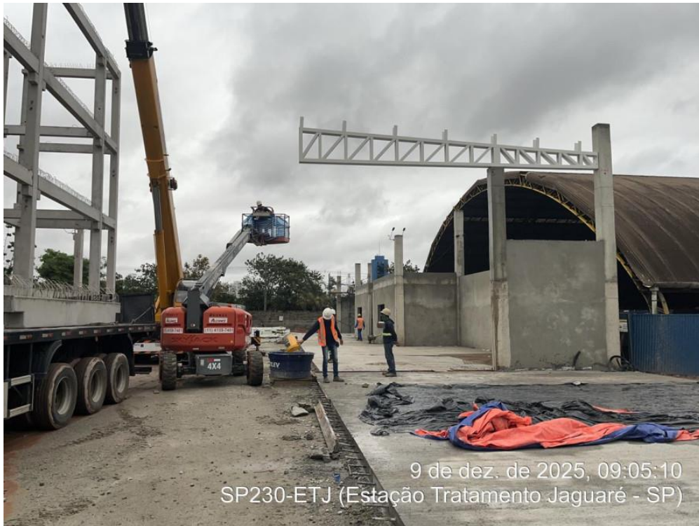
Execução do Prédio da Manutenção (Execução da Estrutura metálica) – Início em julho/2025.
