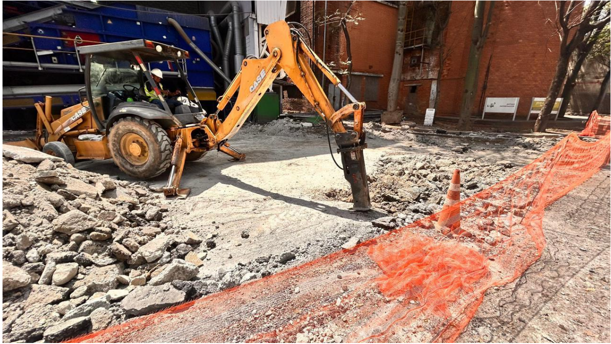
Demolição do piso existente em setembro de 2025.
