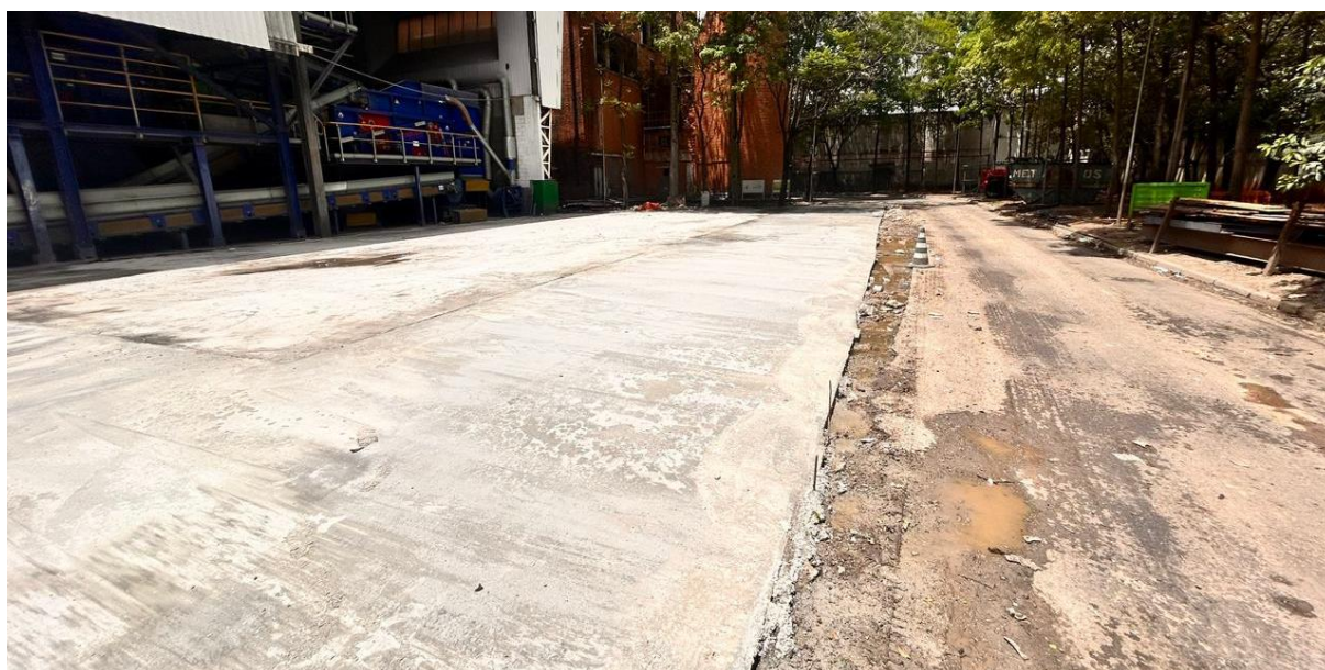
Novo piso finalizado em outubro de 2025.
