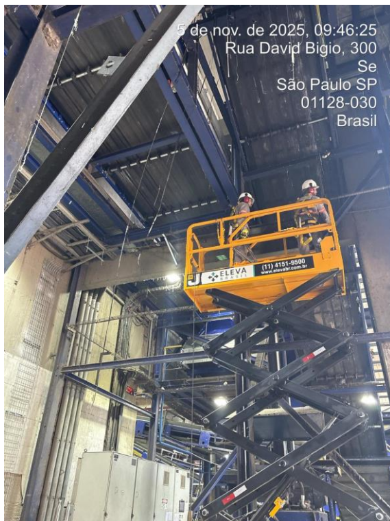
Colocação de suportes e estruturas para as novas instalações elétrica em novembro de 2025.
