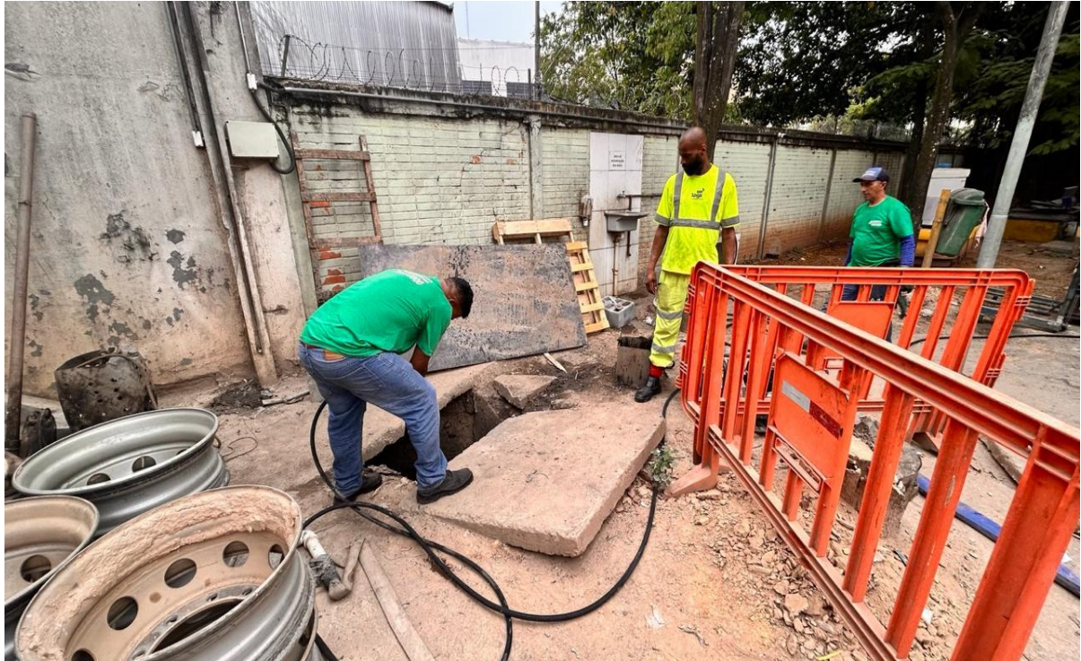
Desobstrução da rede pluvial em outubro de 2025.
