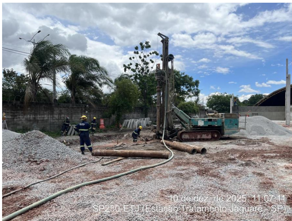
Execução da estaca raiz (na balança) – Início em outubro/2025.
