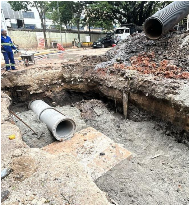
Escavação e substituição de manilhas quebradas em setembro de 2025.
