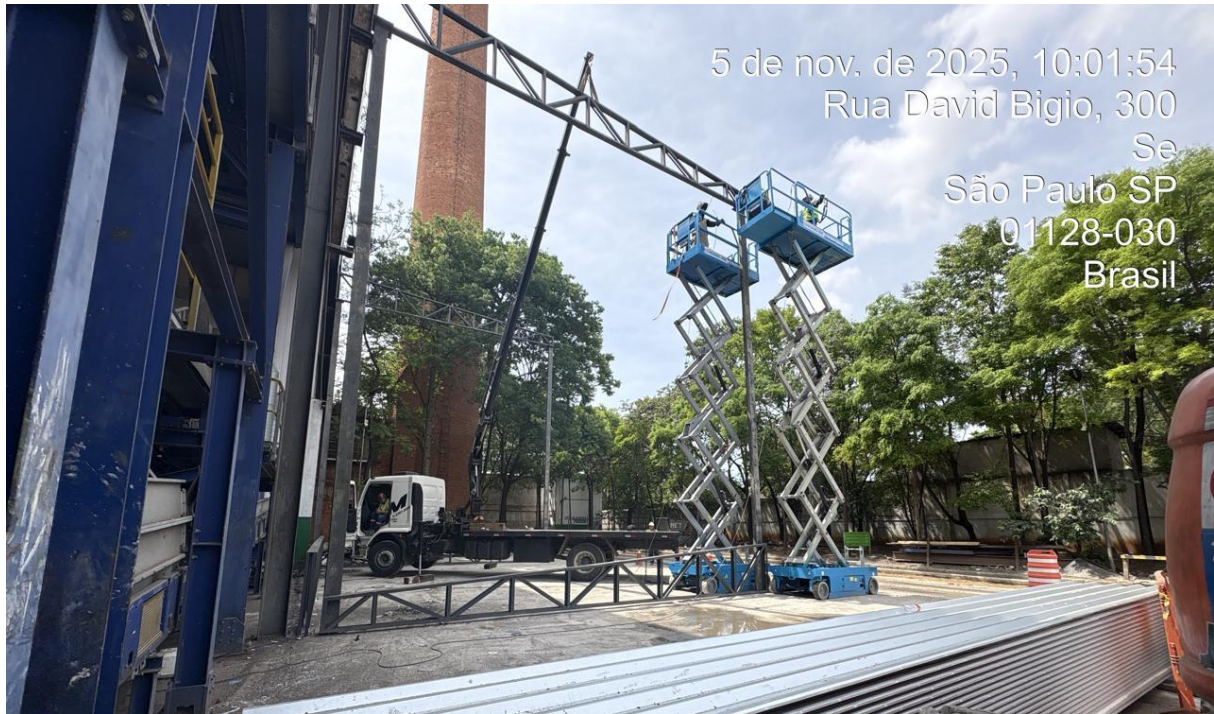
Montagem da estrutura metálica da extensão do Galpão em novembro de 2025.
