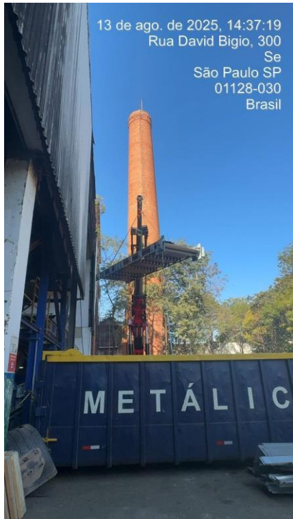
Colocação de nova esteira transportadora e montagem da estrutura metálica para os novos seletores óticos em agosto de 2025.
