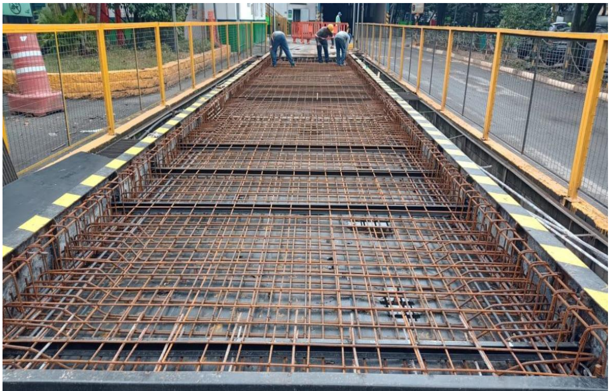
Armação realizada para nova plataforma em maio de 2024.
