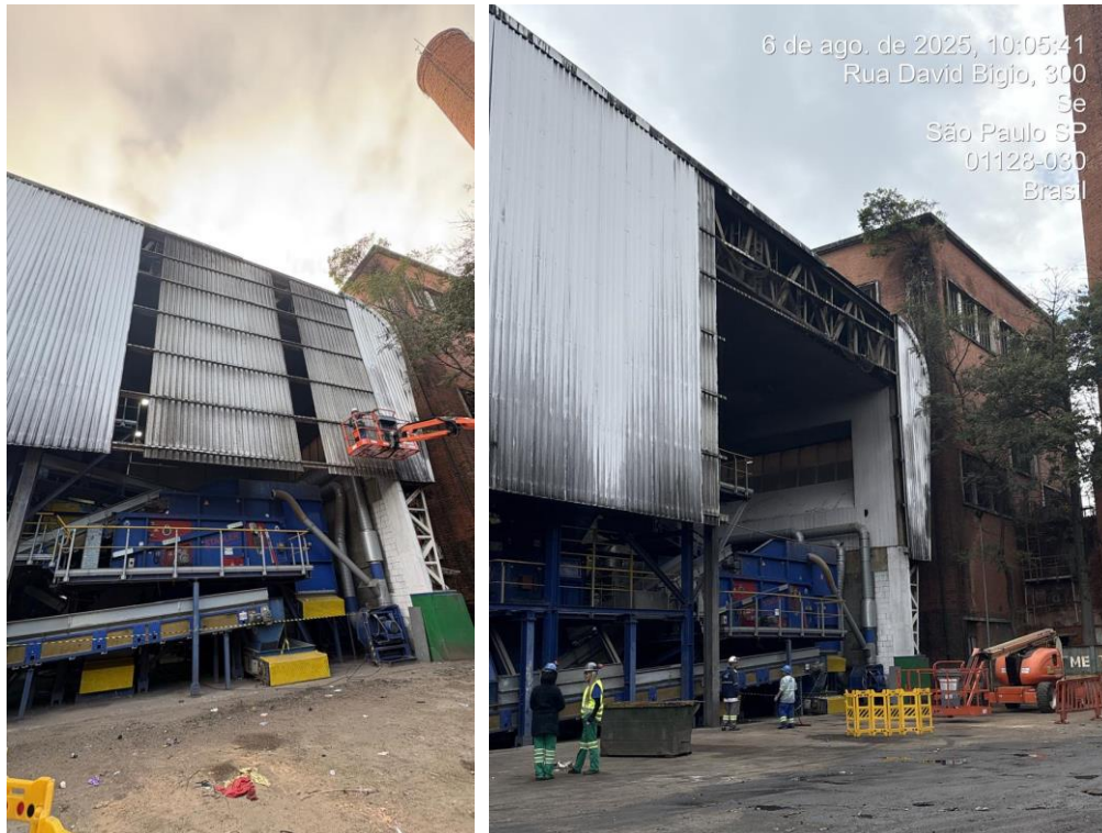
Retirada de painéis de fechamento da parte dos fundos da Central Mecanizada realizada entre 31 de julho e 06 de agosto de 2025.
