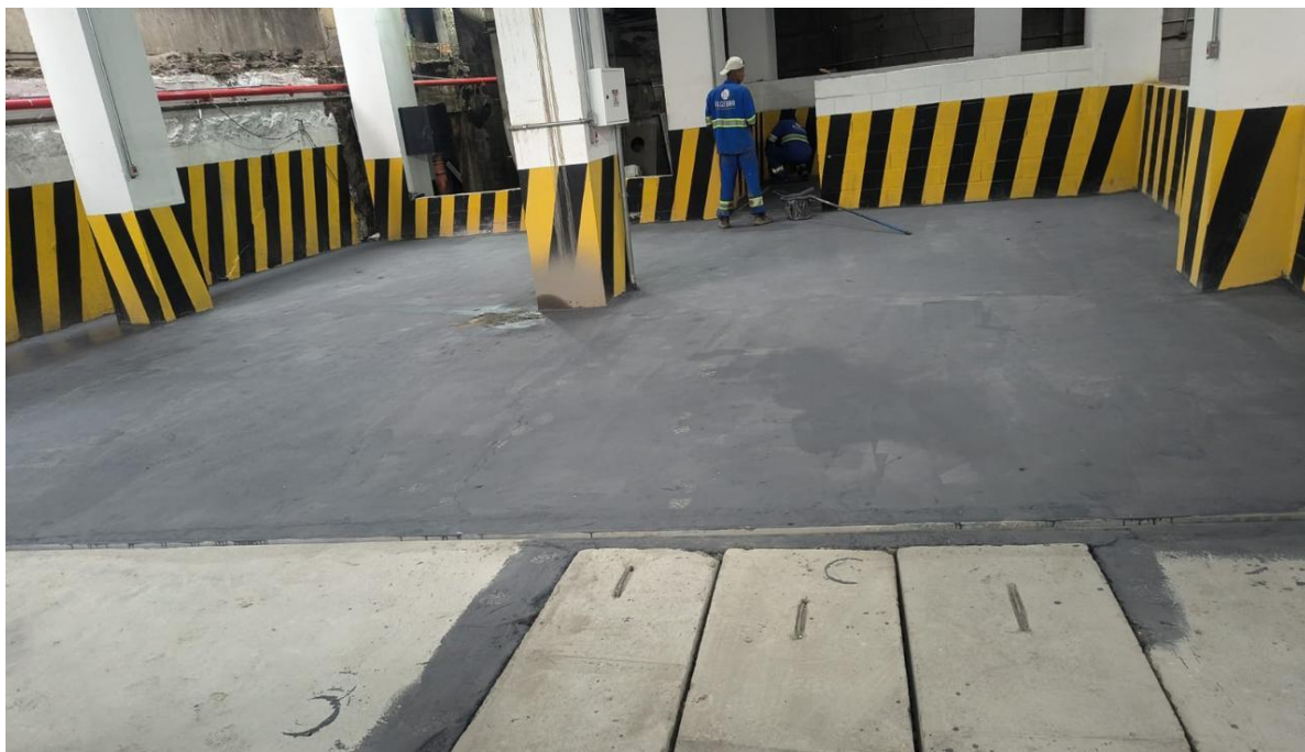
Piso concretado e pintura sendo realizada em agosto de setembro de 2025.
