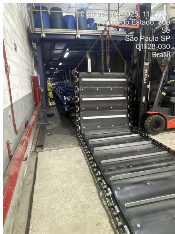
Instalação de nova correia transportadora conectada aos recipientes de armazenamento de materiais recicláveis já modificados em novembro de 2025.
