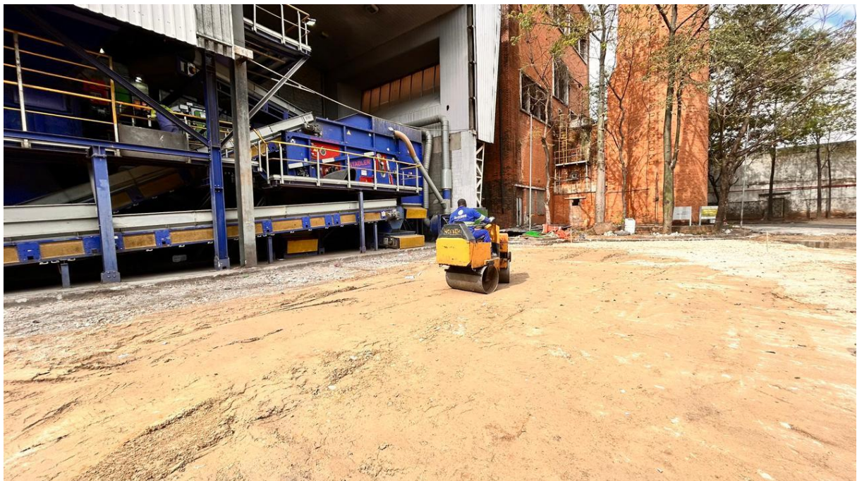
Preparo da base do trecho que recebeu o novo piso em setembro de 2025.
