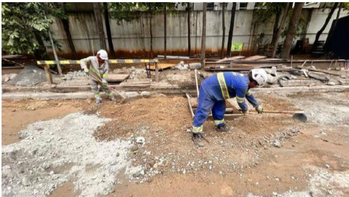
Preparação da base para novo piso em novembro de 2025.
