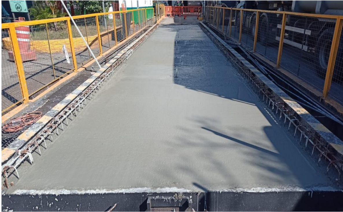
Plataforma concretada em junho de 2024.
