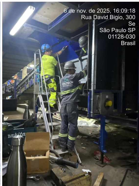
Colocação de suportes e estruturas para as novas instalações elétrica em novembro de 2025.
