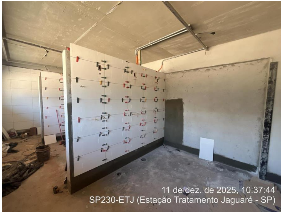
Execução do Vestiário (alvenaria com blocos de concreto, chapisco, reboco, instalações hidráulicas, elétricas e revestimentos) – Início em junho/2025.
