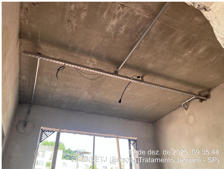
Execução do Posto de Vigia (Execução de armação da laje, Pilares, alvenaria com blocos de Concreto, reboco e chapisco, instalações elétricas e hidráulicas) – Início em julho/2025.
