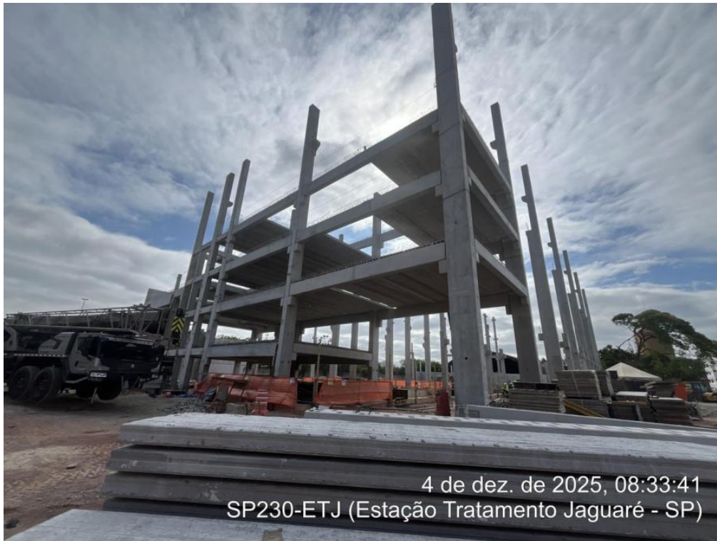
Montagem dos pré-moldados – Início em novembro/2025 e finalizado em dezembro/2025.
