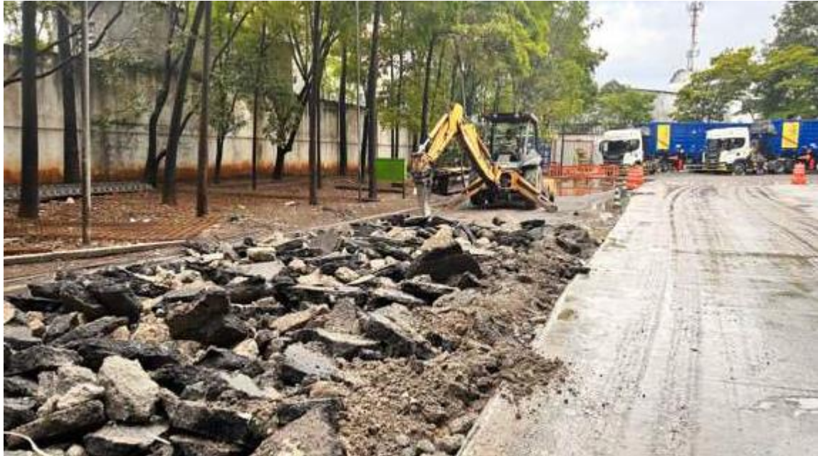
Demolição de trecho do piso da Unidade em novembro de 2025.
