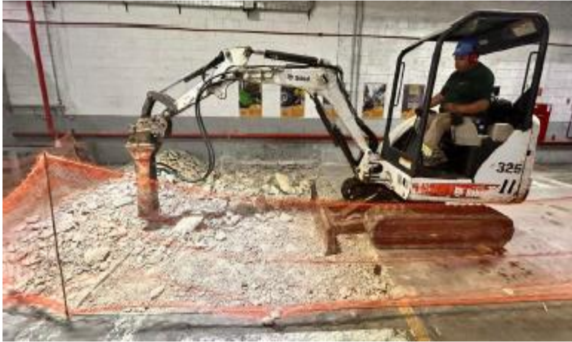
Demolição de trecho do piso da Central Mecanizada de Triagem para reforço e reconstrução em outubro de 2025.
