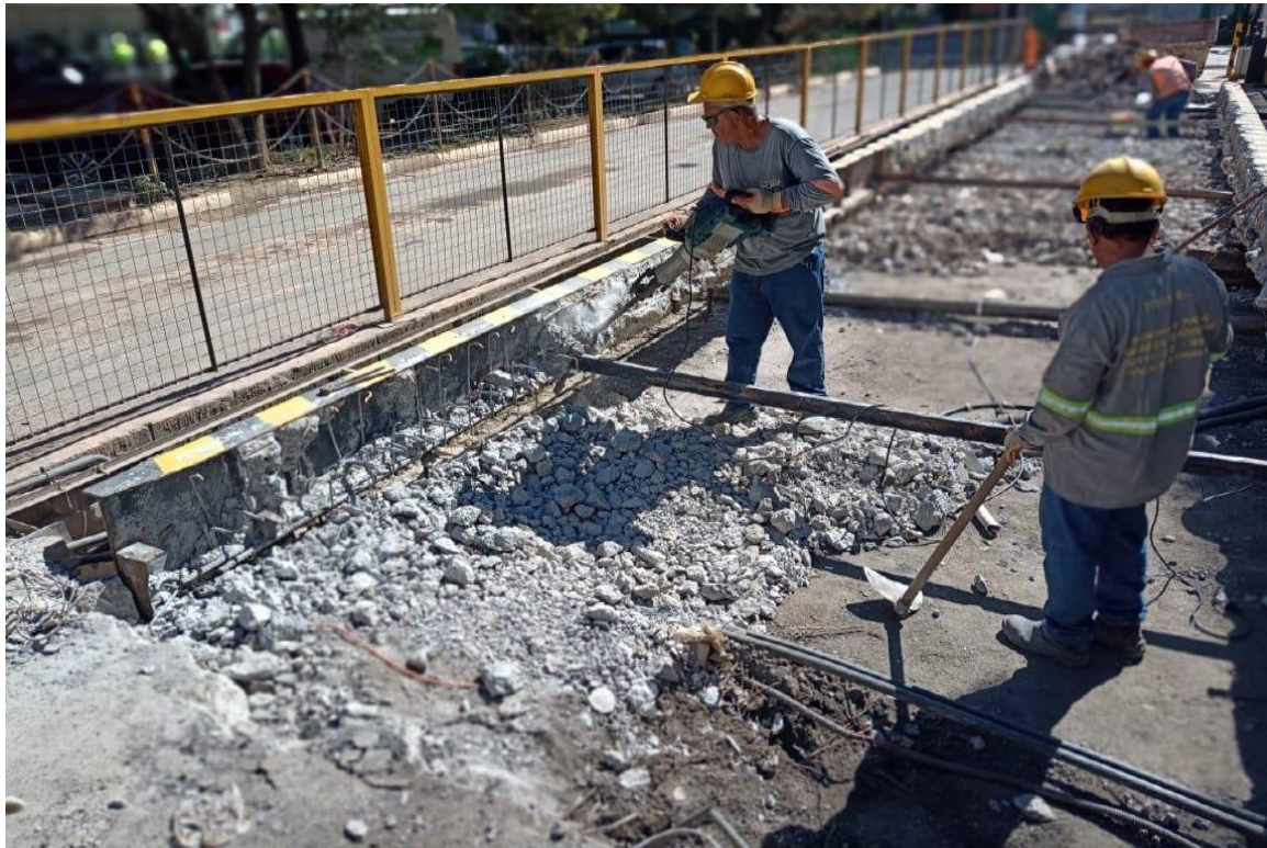
Demolição da estrutura em maio de 2024.
