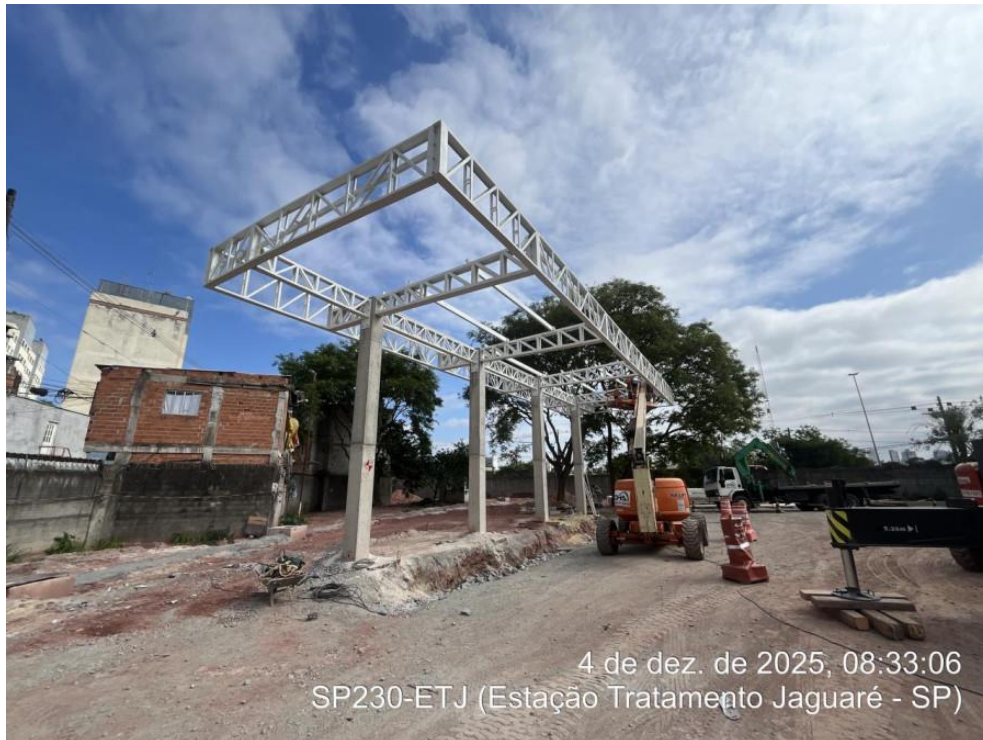
Execução do Posto do combustível, estrutura metálica iniciada em novembro/2025.
