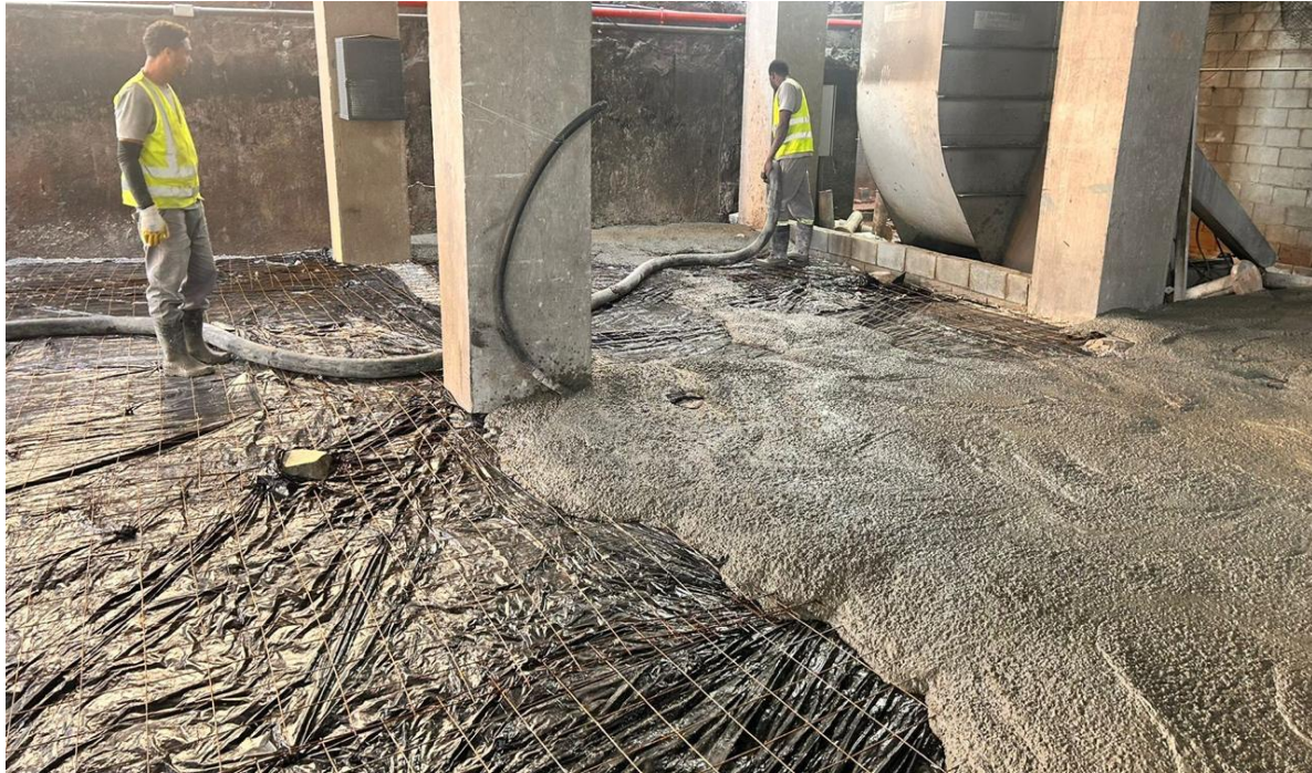
Concretagem do trecho do piso com armação previamente realizada em agosto de 2025.
