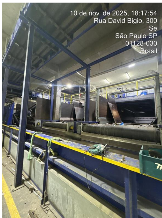
Instalação de nova correia transportadora conectada aos recipientes de armazenamento de materiais recicláveis já modificados em novembro de 2025.
