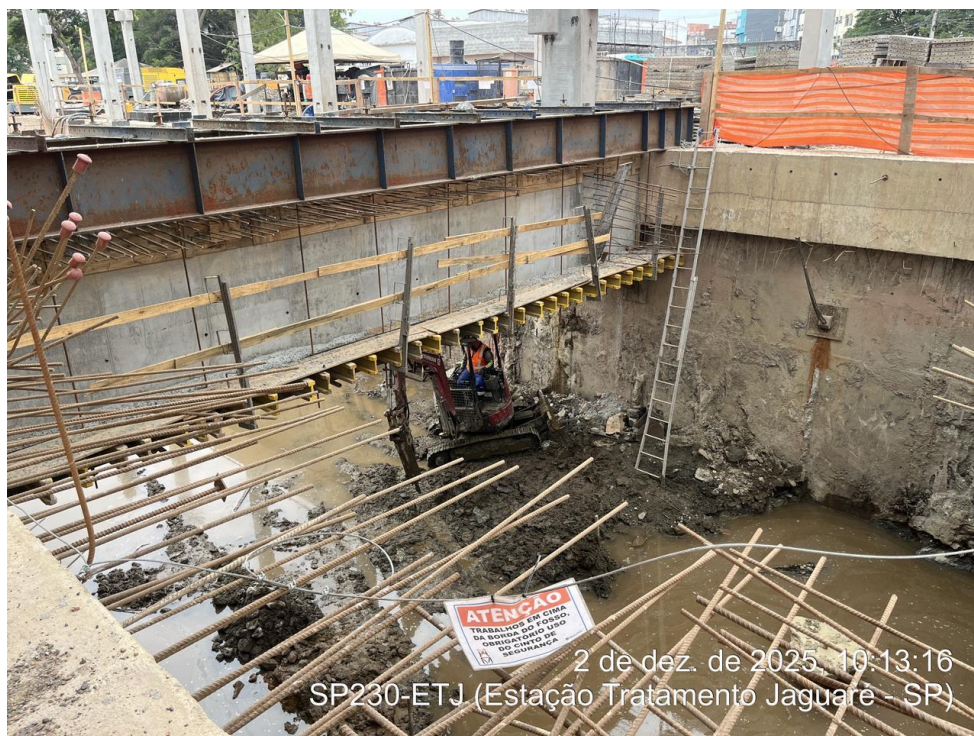
Execução de viga no fosso do transbordo – Início em novembro/2025.
