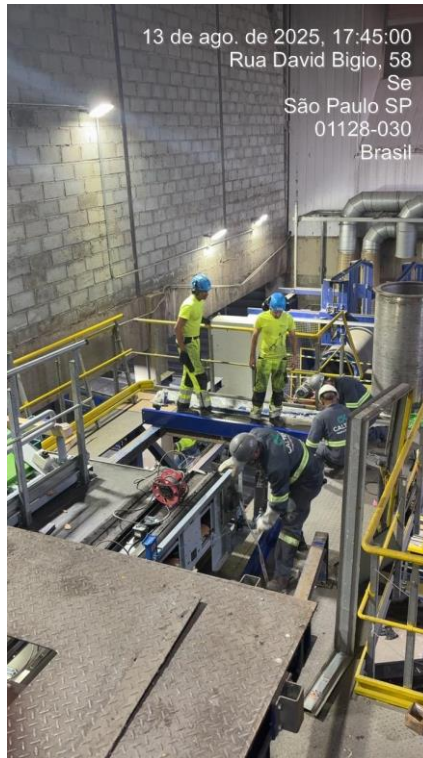
Colocação de nova esteira transportadora e montagem da estrutura metálica para os novos seletores óticos em agosto de 2025.
