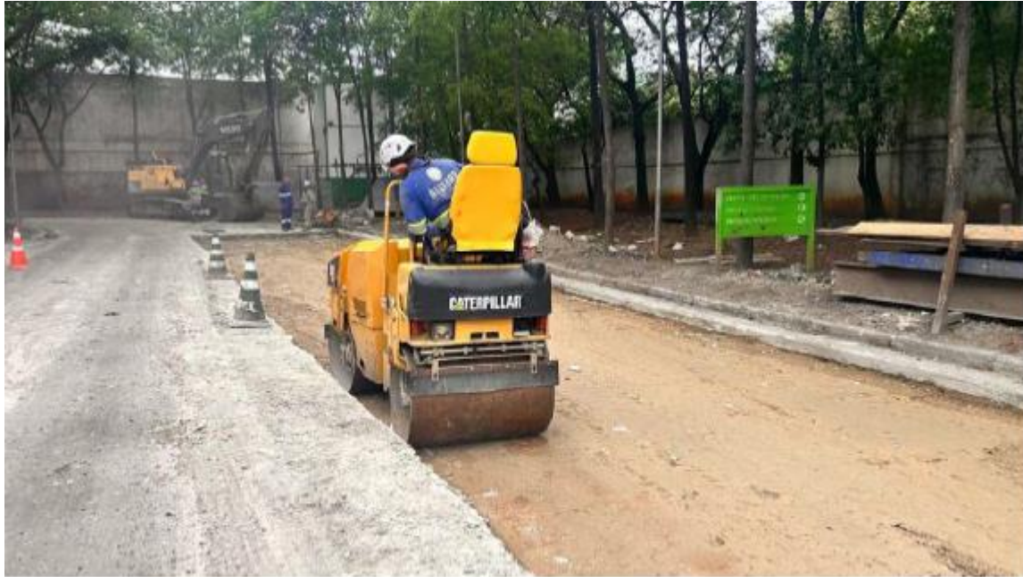
Compactação da base para novo piso em novembro de 2025.
