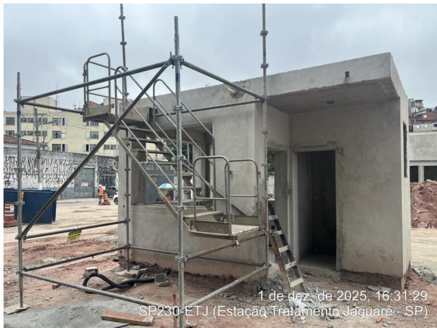
Execução da Portaria (instalações elétricas, execução do contrapiso e acabamentos) – Início em junho/2025.
